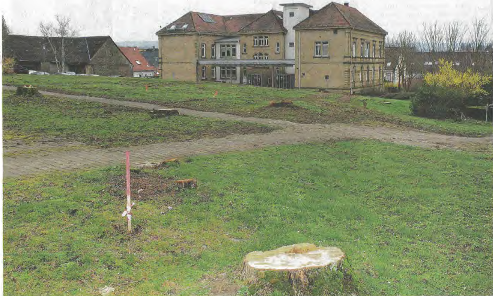
Die auf dem Gelände stehenden Bäume sind bereits gefällt. Die Lage des künftigen Baukörpers wurde mit Markierungsstangen abgesteckt.
