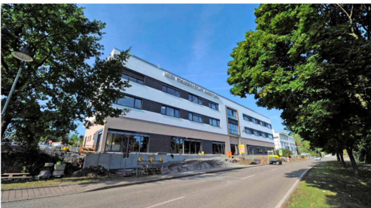
Verkehrsgünstig gegenüber dem Sportplatz im Wiesental in der Austraße gelegen, ist das Medizentrum Zabergäu nicht nur am Schriftzug, sondern auch an der zeitgemäßen Architektur zu erkennen. Fotos: Dennis Mugler
